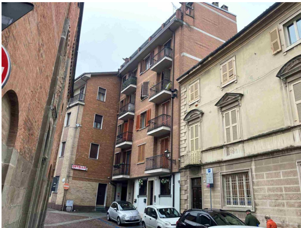
Foto 1 – Prospetto da Piazza Santa Maria Canale
